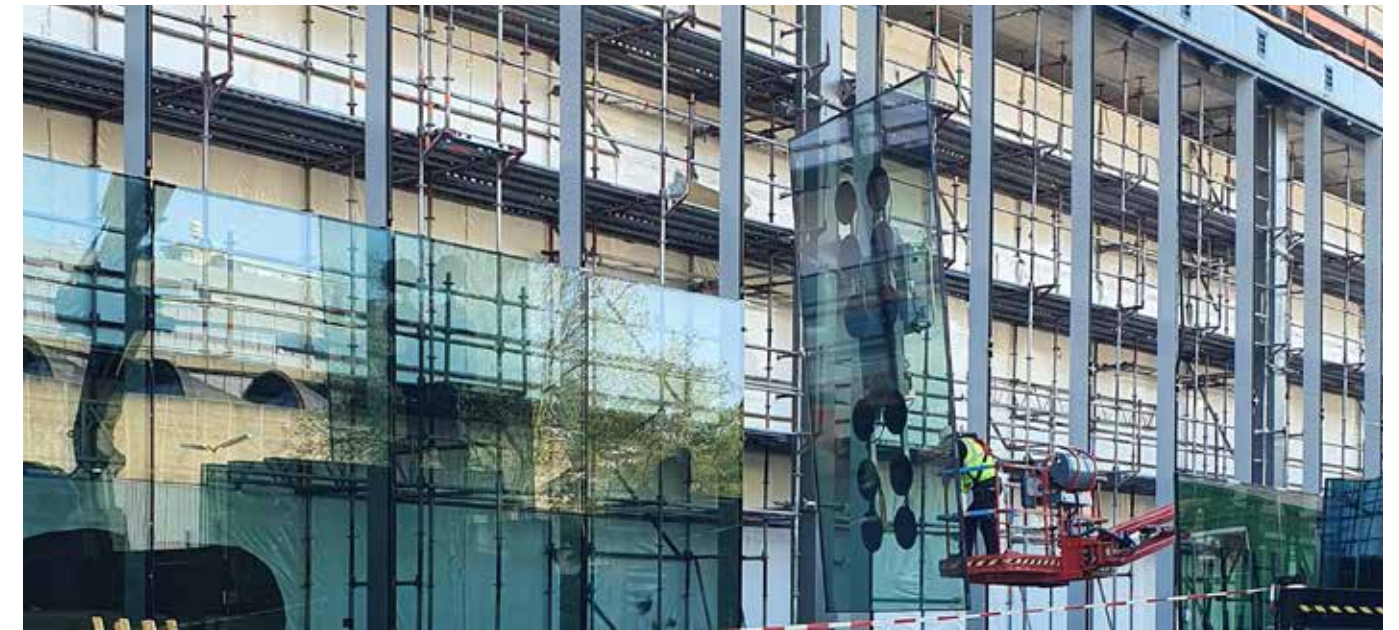
Dit project wordt gerealiseerd door BAM Bouw & Techniek, terwijl Stevens Van Dijk het bouwmanagement en de directievoering verzorgt.
