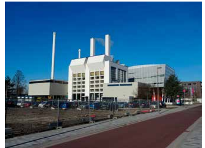
Warmtekrachtcentrale (1957), architect J. van den Broek / J. Bakema.
