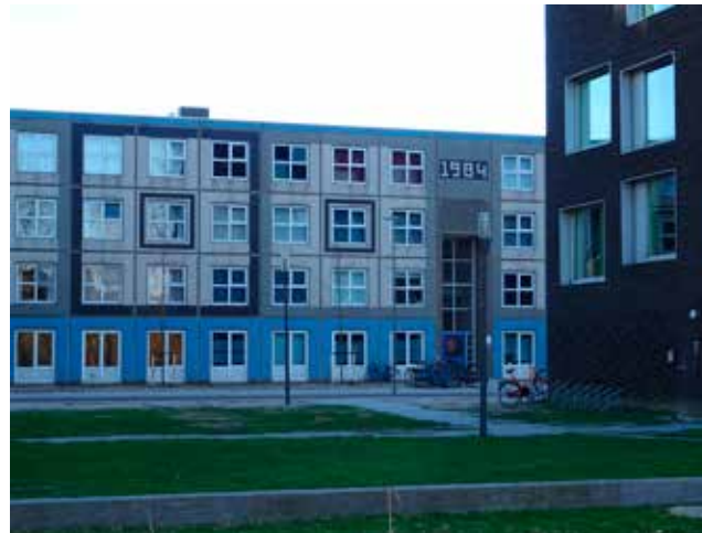
Voorbeeld van een woningcomplex voor studenten. Op de foto het complex Korvezee. Architect C. Weeber (1984).
