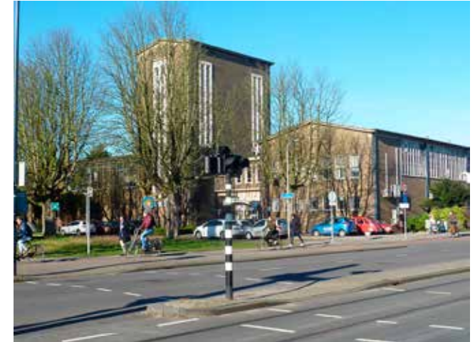
Voorbeeld van een zelfstandig gebouw ontworpen naar een specifiek (onderwijs)gebruik. Op de foto het Kramers Laboratorium. Architect C. A. Abspoel (1950).
